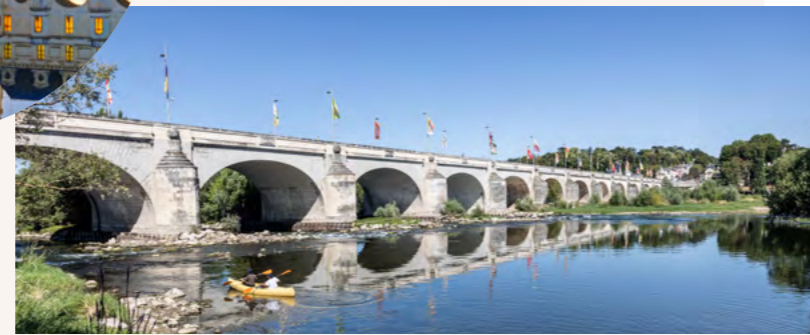
Pont Wilson, Tours
